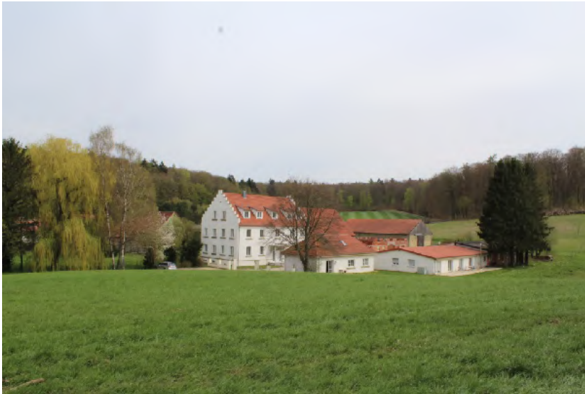
Foto 1 Wohn- und Nebengebäude Zustand, 2015
