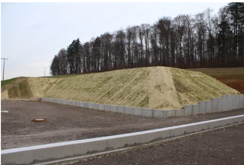
Foto 6 Einschnittsböschung neuer Sandreitplatz Zustand, 2018
