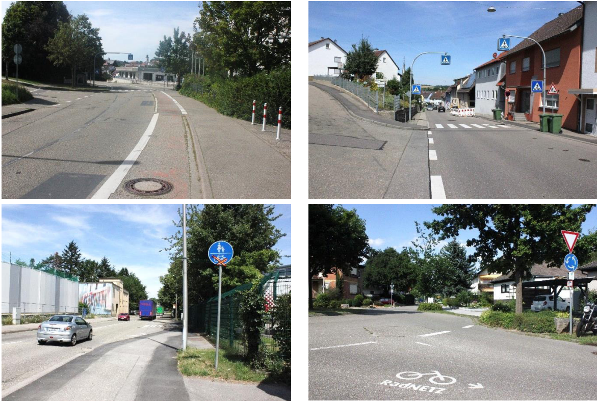
Abbildung 23: Radfahrstreifen in der Max-Planck-Straße (o. l.); Radverkehr im Kfz-Mischverkehr bei Tempo 50 in der Steinzeugstraße (o. r.); Missverständliche Auflösung der Benutzungspflicht für Radfahrende in der Pforzheimer Straße (u. l.); gekennzeichnete Verlauf des RadNETZ Baden-Württemberg (u. r.)
