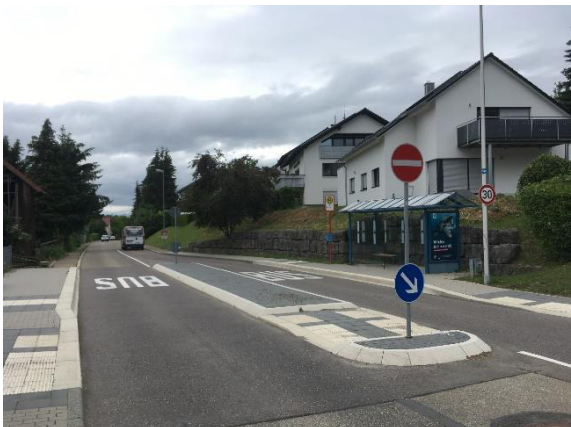
Abbildung 8: Querungsanlage mit Querungsinsel in Sprantal (links); Angedeutete Möglichkeit des flächenhaften Querens in der Georg-Wörner-Straße (rechts)
