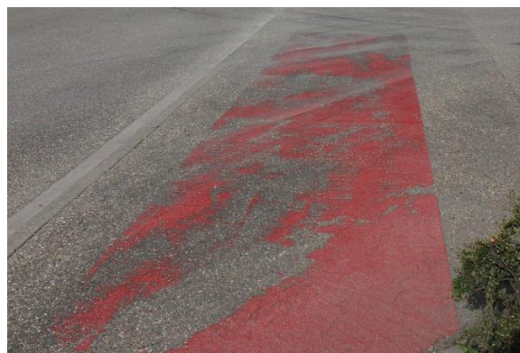
Abbildung 25: Rot markierte Radfurt am Kreisverkehr B 294/ Friedrich-List-Straße (links); verblasste Markierung der Furt in der Rinklinger Straße (rechts)
