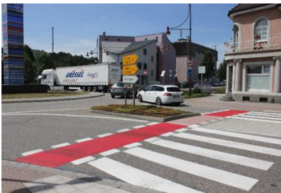
Abbildung 25: Rot markierte Radfurt am Kreisverkehr B 294/ Friedrich-List-Straße (links); verblasste Markierung der Furt in der Rinklinger Straße (rechts)
