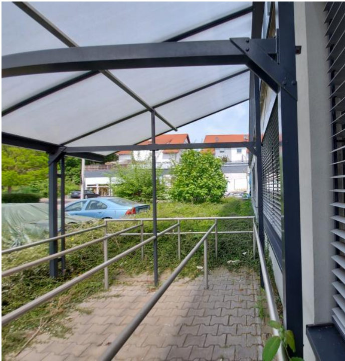
Abbildung 4: Gebüsch zwischen Parkplatz und Gebäude
