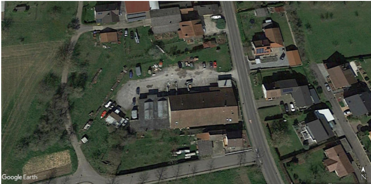
Abb. 1: Luftbild aus dem Jahre 2021 mit Lage des Plangebietes zwischen Hügellandstraße im Osten, Kirchstraße im Süden und einem asphaltierten Feldweg im Westen.
