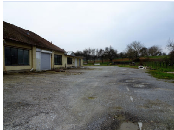
Foto 2: Der befestigte Hof des ehem. Gewerbegebäudes.
