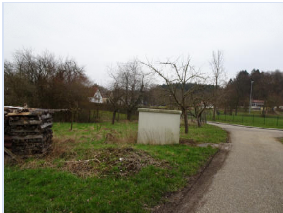
Foto 7: Blick auf das kleine Flurstück 731/1 mit Trafo-Station im Westen. Dahinter die Obstbäume von Flurstück 729.
