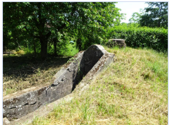
Foto 8: Der betonierte Treppeneingang zum alten Pumpwerk auf Flurstück 729.
