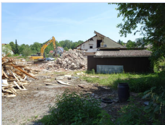
Foto 3: Der Rückbau des Gewerbegebäudes am 17.06.2021 von der Westseite aus gesehen.
