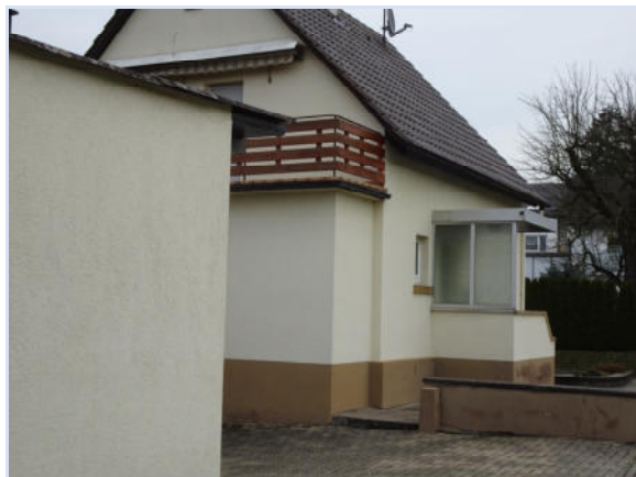
Foto 9: Das bestehende Wohnhaus im Südosten des Plangebietes mit Nebengebäuden.
