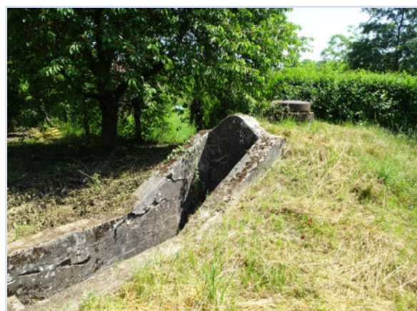
Foto 6: Der betonierte Treppeneingang zum alten Pumpwerk auf Flurstück 729.
