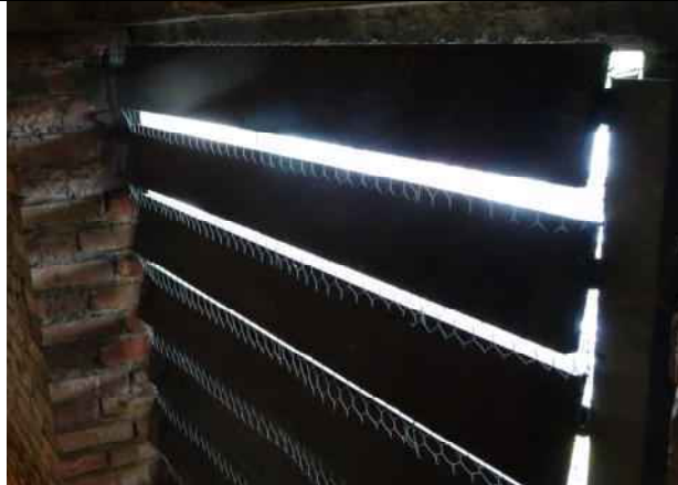
Foto 11: Die Öffnungen hinter den Uhren sind mit feinmaschigem Draht verschlossen worden.
