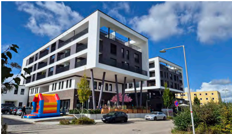
Mit herausragender Architektur bestechen die beiden neuen Gebäude der Firma Südbau an der Hermann-Beuttenmüller-Straße. Foto: Marcel Winter/Stadt Bretten
