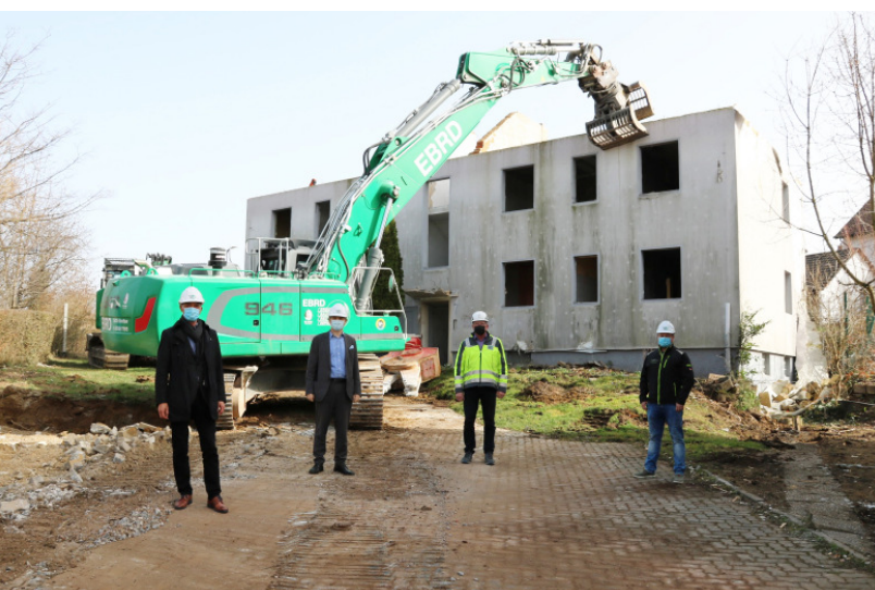
Baggerbiss im Wannengeweg 7 mit v.l. Gerd Lehmann, Geschäftsführer der Städtischen Wohnungsbau GmbH, Bürgermeister Michael Nöltner, Thomas Zehlicke, Betriebsleiter der EBRD GmbH & Co. KG sowie Daniel Veit aus dem Bereich technische Betreuung bei der Städtischen Wohnungsbau Foto: Stadt Bretten
