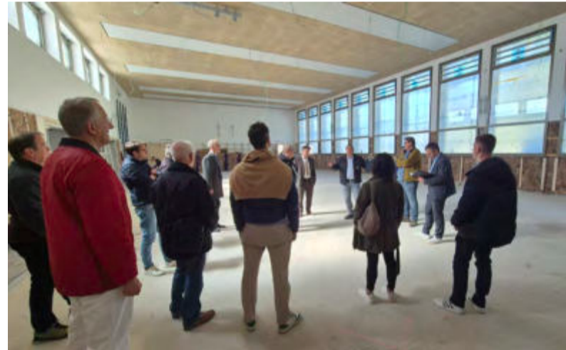
Am Montag machte sich der Gemeinderat gemeinsam mit Oberbürgermeister, Bürgermeister, dem Bauleiter und Mitarbeitern des Bauamts ein Bild vor Ort. Die neue Jahnhalle wird bis zum neuen Schuljahr fertig sein. Foto: Marcel Winter/Stadt Bretten
