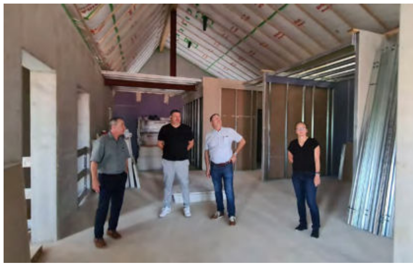
Bei einer Besichtigung verschaffte sich Oberbürgermeister Martin Wolff gemeinsam mit Frank Bohmüller, Markus Geiser und Alexandra Schmidt ein Bild vom Baufortschritt.
