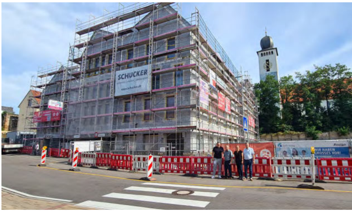
Das Gesundheitszentrum an der Sporgasse nimmt Gestalt an. Während die Arbeiten an der Fassade für jeden sichtbar voranschreiten, läuft auch der Innenausbau auf Hochtouren. Fotos: Marcel Winter/Stadt Bretten
