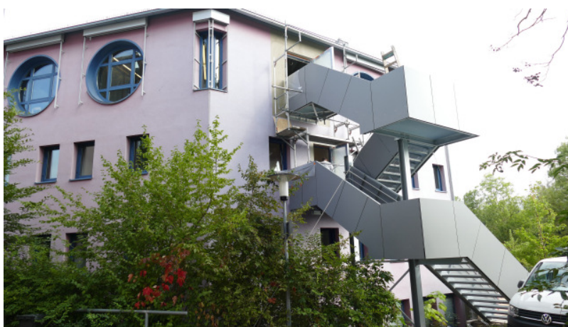
Foto: Die neue Außentreppe ist vom Dachgeschoss und 1. Obergeschoss aus zugänglich und dient als Fluchtweg bei Veranstaltungen bis 150 Personen Foto: Stadt Bretten
