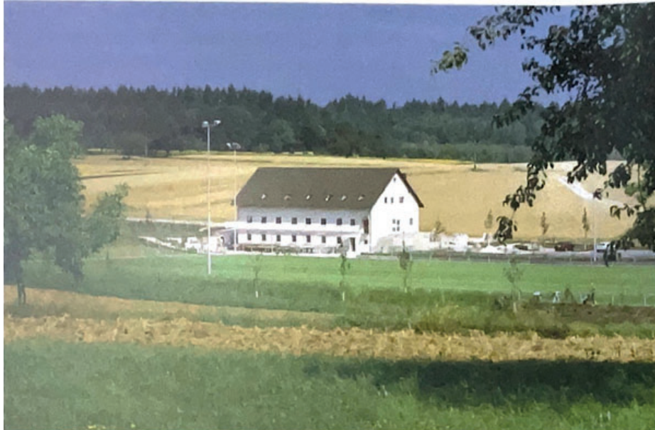
Letzte Arbeiten vor der Sportplatzeinweihung August 1999
